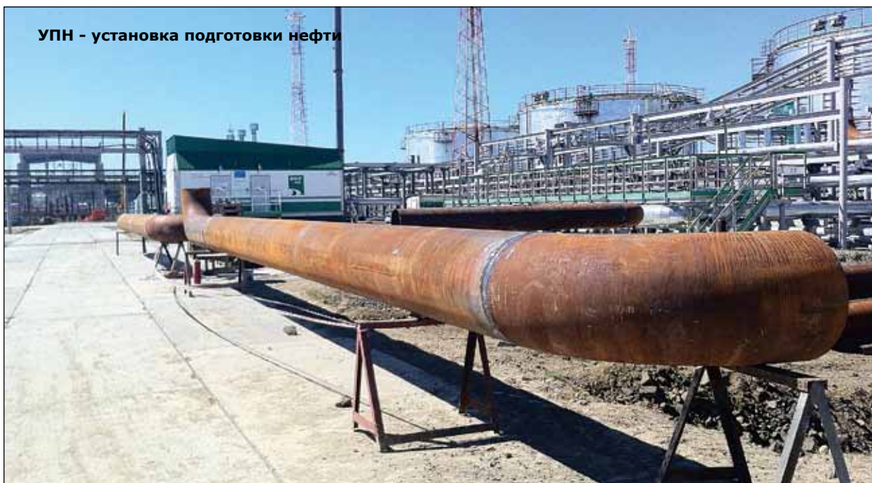
УПН-1. Реконструкция линии 1.2. Трубная заготовка диаметром 630 мм
