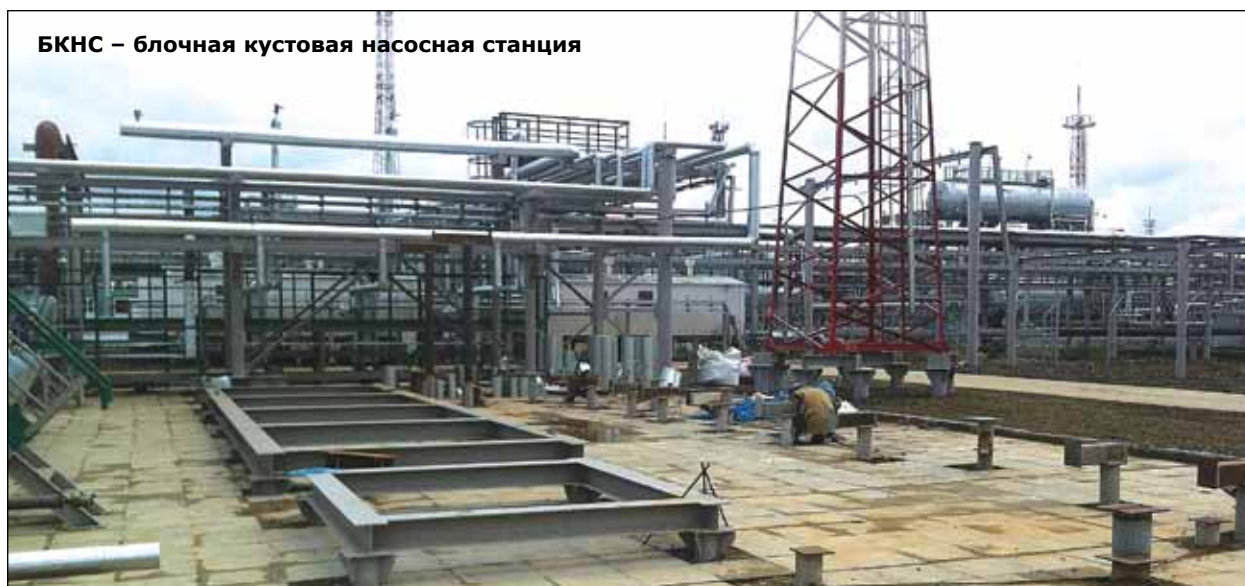
БКНС-2. Фундамент под печь ПТБ-10N№4 на площадке огневых подогревателей
