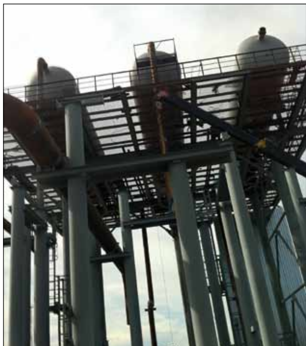
УПН-1. Реконструкция. Площадка КСУ. Ст 4.
