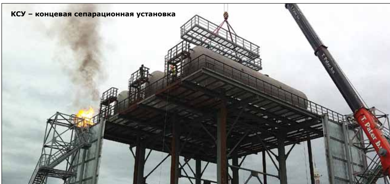
Верхняя площадка обслуживания сепаратора КСУ (монтаж)
